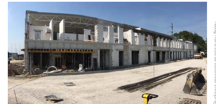
Budowa nowego magazynu firmy.
