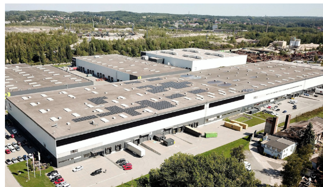
Centrum logistyczne ADLER w Ostrawie - pokryte panelami fotowoltaicznymi.
