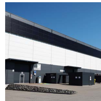
Zainstalowane systemy fotowoltaiczne.
